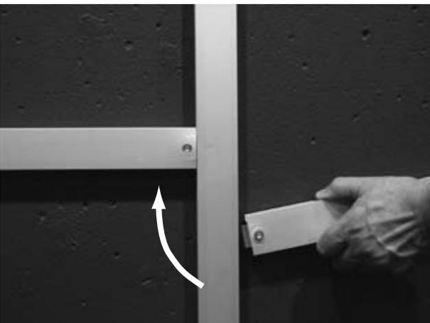
3. rechte waagerechte Strebe drehend mittig einsetzen, an linker Strebe ausrichten. Innensechskant-Schrauben anziehen, danach die senkrechte Strebe durch Anziehen der Schrauben fixieren
