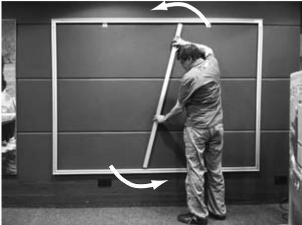
1. senkrechte Strebe durch Drehen mittig im Rahmen platzieren. Schrauben nur leicht anziehen, damit Strebe noch positioniert werden kann
