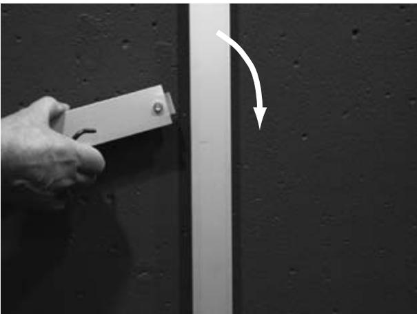
2. linke waagerechte Strebe drehend mittig einsetzen. Innensechskant-Schrauben anziehen
